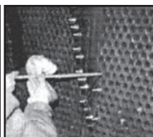
Трубна дошка (коллектор) при введенні в теплообмінну трубку телеендоскопа
