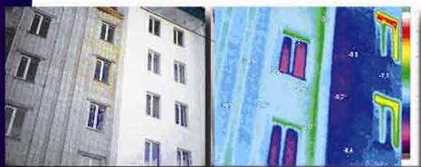
Видимое и тепловое изображение фасада жилого здания
